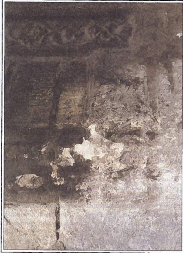
Mal de la piedra Meteorización química en calizas
